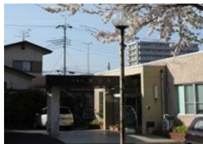
1980年、街の中心部に誕生した特別養護老人ホーム「寿山荘」。1993年にデイサービスセンターとショートステイ、1996年に老人介護支援センター、ホームヘルプサービス事業所を開設。
